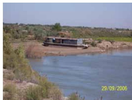
Рис.4. Плавучая насосная станция
