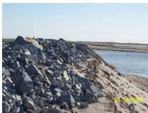
Рис.7. Укрепление дамбы каменной наброской
