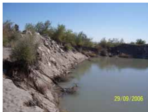
Рис.2. Размыв оголовки дамбы
