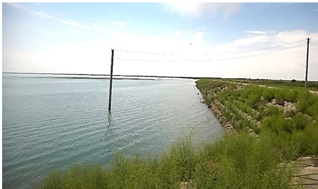
Северная дамба Междуреченского водохранилища, май 2017 года
