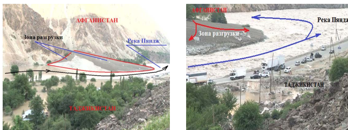
Рис. 3. Трансграничная ЧС. 1 - конус выноса селя. 2 – устройство прорана в русле реки Пяндж от селевыносов
